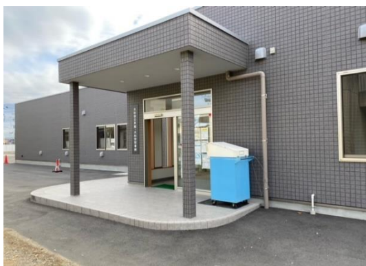
<大和田図書館 仮設 外観>
